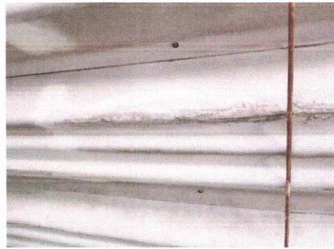
Foto 4: Se observa la filtración del agua en temporada de lluvias.
